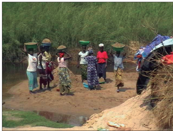
Mujeres: no importa el tipo de trabajo que sea, siempre presentes allá donde haga falta echar una mano. En este caso transportando en la cabeza arena del río para las obras en Cazombo.
