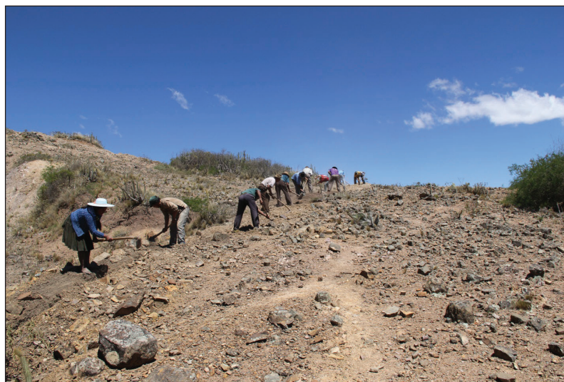
Beneficiarios colaborando con su mano de obra en la realización de zanjias para la canalización.
