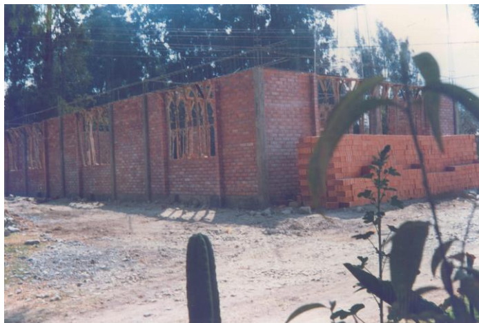
Comienzo de la construcción de la ampliación del internado
