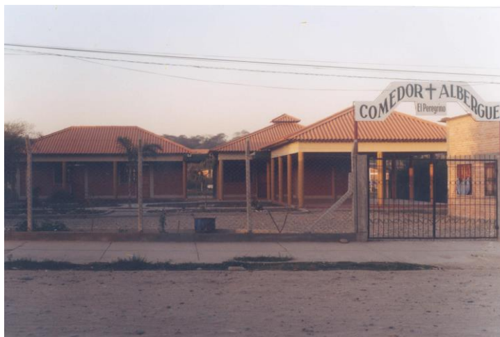
El albergue recién terminado
