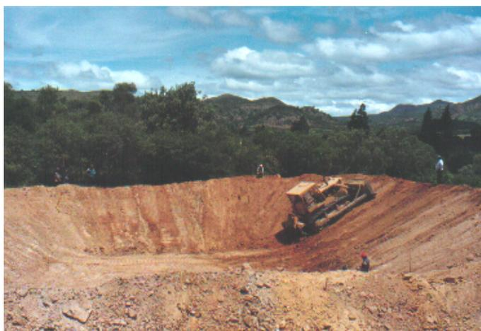
*Excavación y conformación de los taludes de un atajado con maquinaria pesada*
