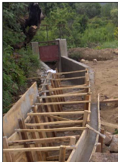
Sustituyendo los muros de tierra por muros de hormigón
