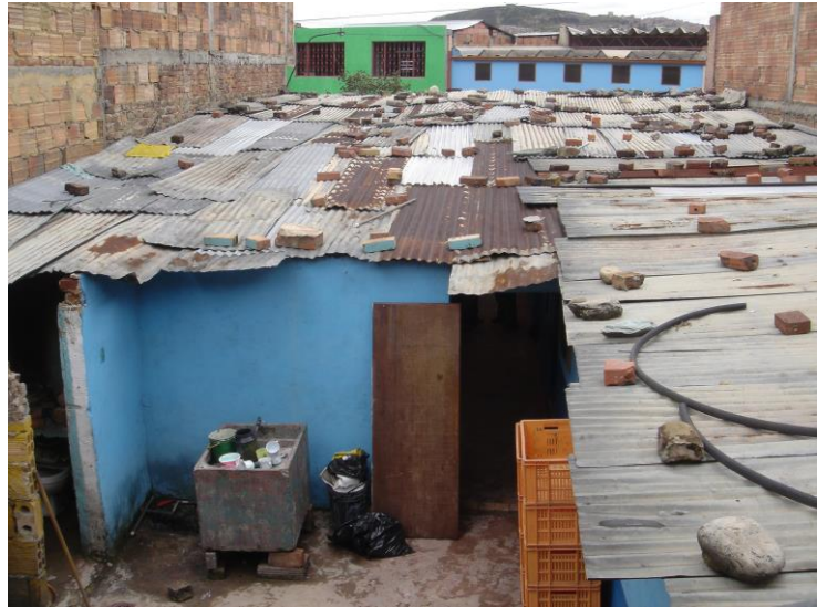
En la foto la antigua guardería... Ya sólo es recuerdo, pero no hay que pararse y vamos a ampliar la nueva.
