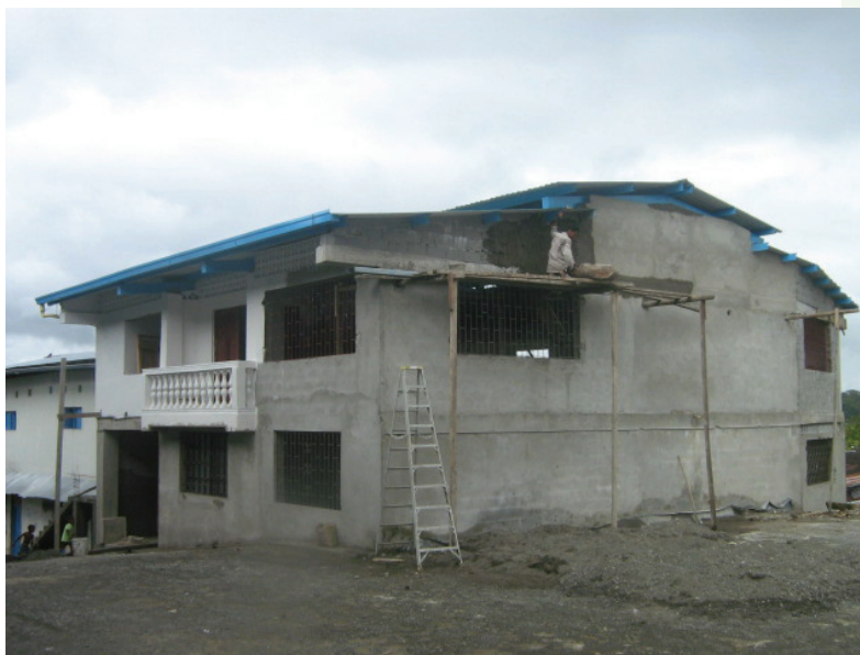
El nuevo edificio en plena construcción.
