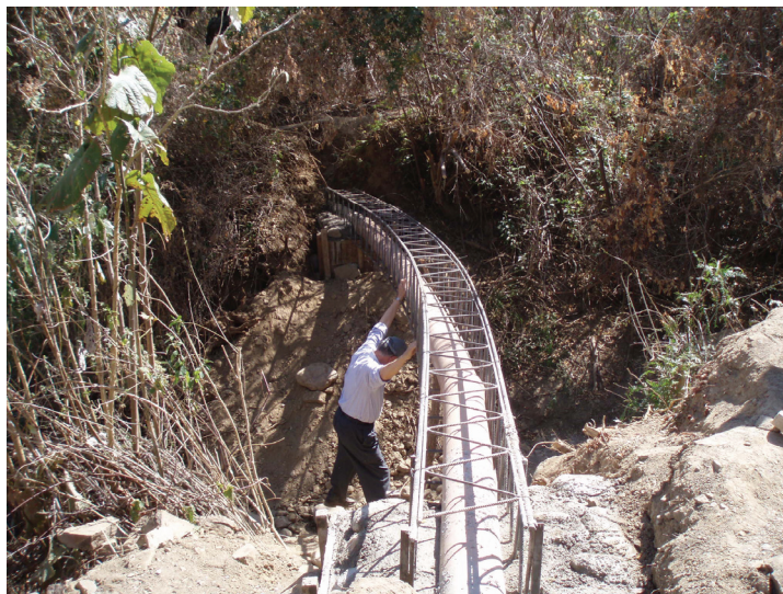
En ocasiones los canales tienen que salvar cortes del terreno. En éste, el P. Antonio Vidales colabora activamente “sujetando” la viga de apoyo.
