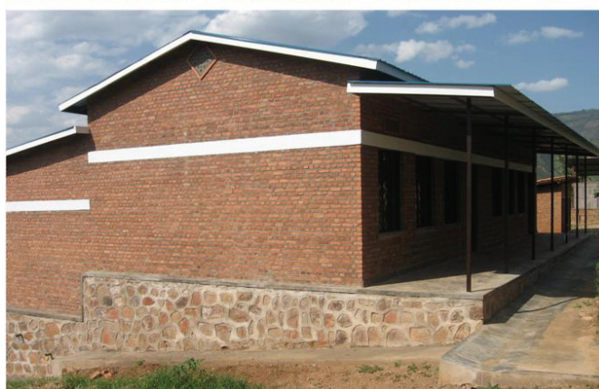
Frente y lateral de la escuela de albañilería de Kabuga.
